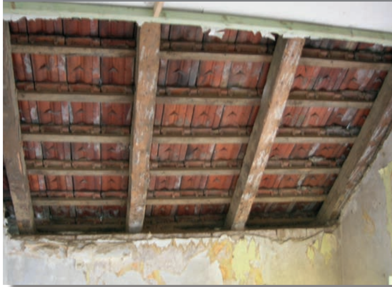
ENTFERNUNG DER ALTEN DÄMMUNG
